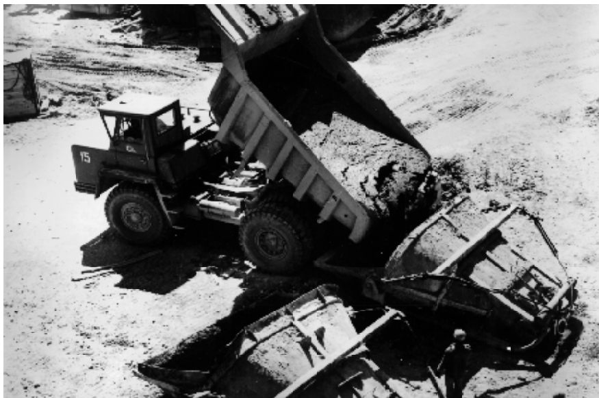
Рис. 2.26 а) пакет вибраторов на пневмоходу; б) самосвал БелАЗ и бадья 8 м 3
