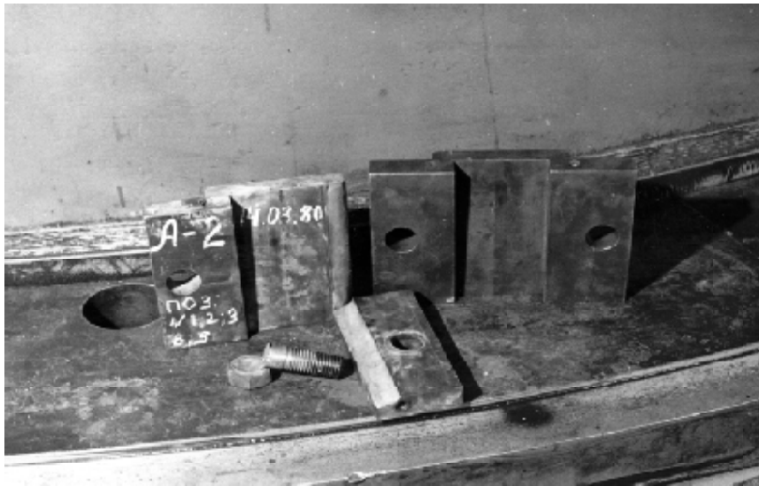
Рис. 3.18 Разрушение сухарей и крепежа турбинного подшипника
