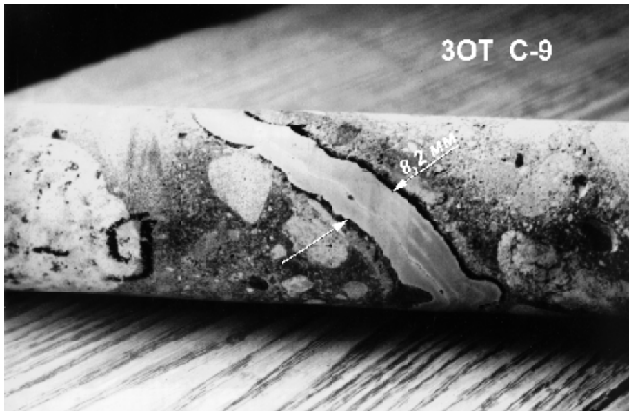
Рис. 2.45 Фотография ядра, выбуренного из растянутой зоны бетона напорной грани после инъекции. Хорошо виден “Родур”, заполнивший трещину
