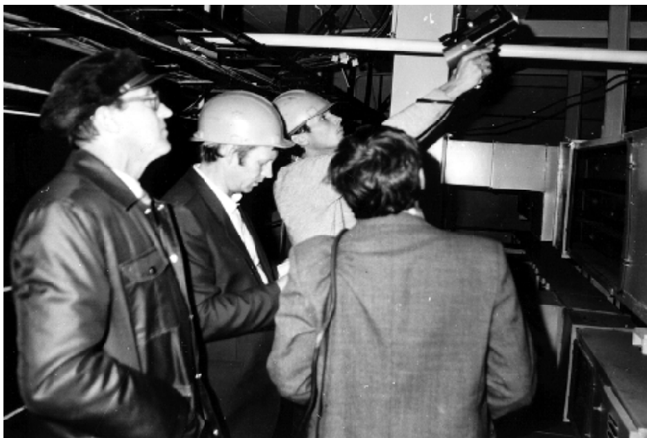
Рис. 4.59 Измерение с помощью тепловизора температуры шинопровода цепи возбуждения в период испытания генератора
