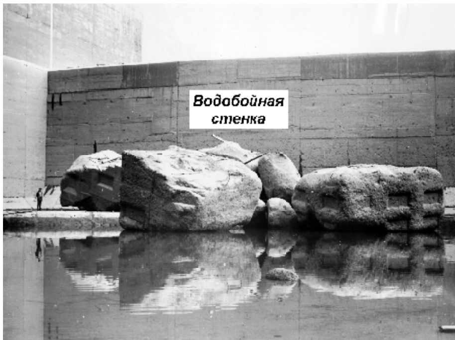
Рис. 2.53 а) разрушение дна водобойного колодца; б) вынос потоком плит крепления дна
