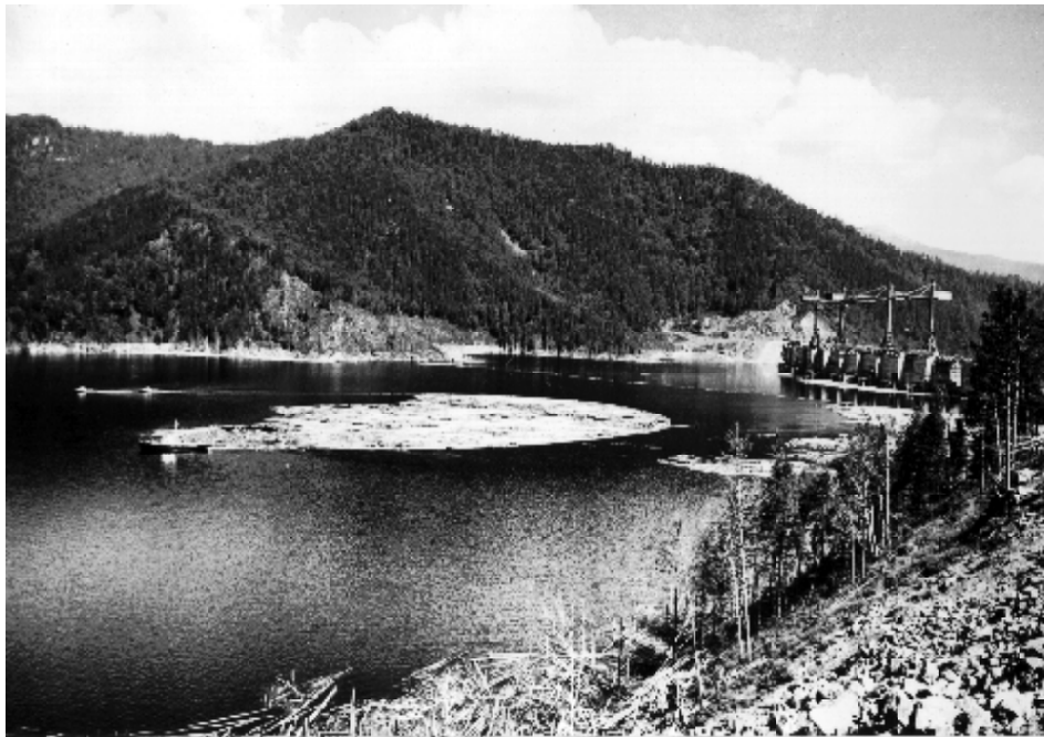
Рис. 7.16 Формирование кошелей древесной массы с помощью катеров и отвод их к местам отстоя
