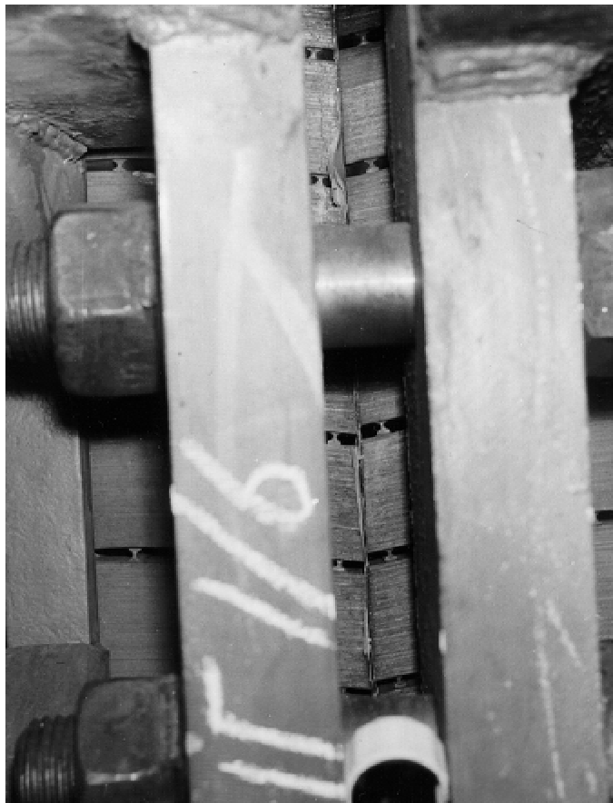
Рис. 4.34 Деформация железа статора красноярского гидрогенератора в месте стыка секторов сердечника
