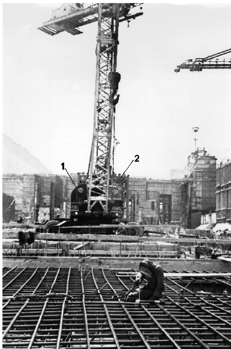
Рис. 2.50 Вид автомобильного (1) и башенного (2) кранов, установленных на плитах водобойного колодца
