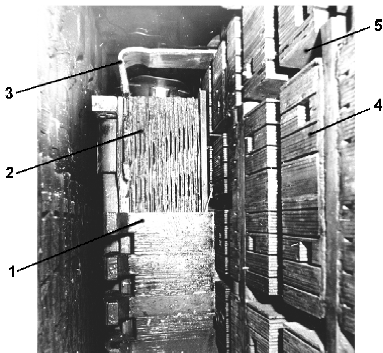
Рис. 4.42 Часть обмоткодержателей катушек полюсов снята
