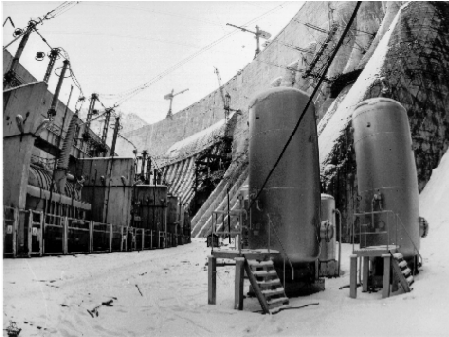
Рис. 5.6 Воздухосборники системы отжатия воды из камеры РК для режима СК
