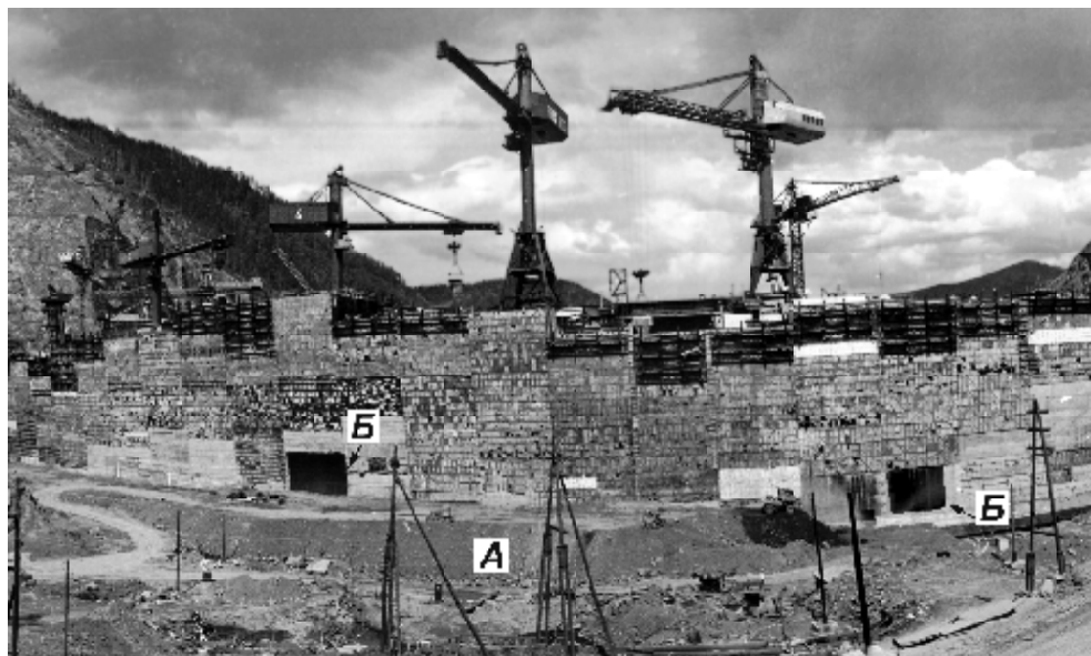
Рис. 2.21 Внешний вид работ по производству понура перед станционной частью плотины
