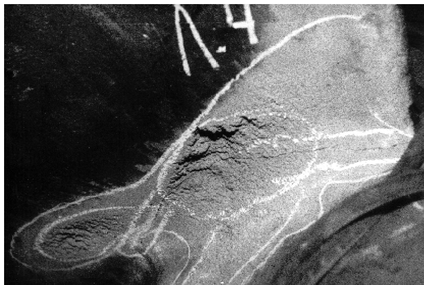
Рис. 3.24 Трещина сквозная на входной кромке рабочего колеса турбины № 10 длиной 495 мм после наработки агрегата 24559 часов
