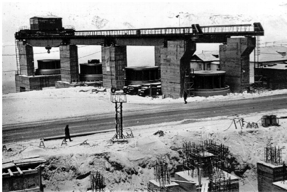
Рис. 7.2 Причал разгрузки рабочих колес с водного транспорта на Красноярской ГЭС
