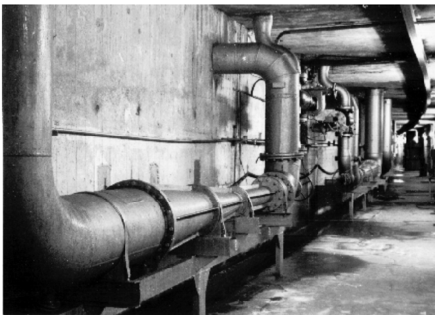
Рис. 5.2а Внешний вид эжекторов, установленных в галерее здания Саяно-Шушенской ГЭС
