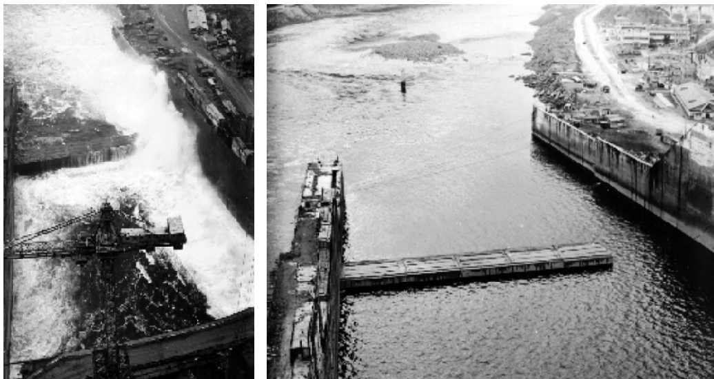
Рис. 2.51 Слева – сосредоточенный сброс воды через водобойный колодец; справа – разрушенная секция водобойной стенки водобойного колодца
