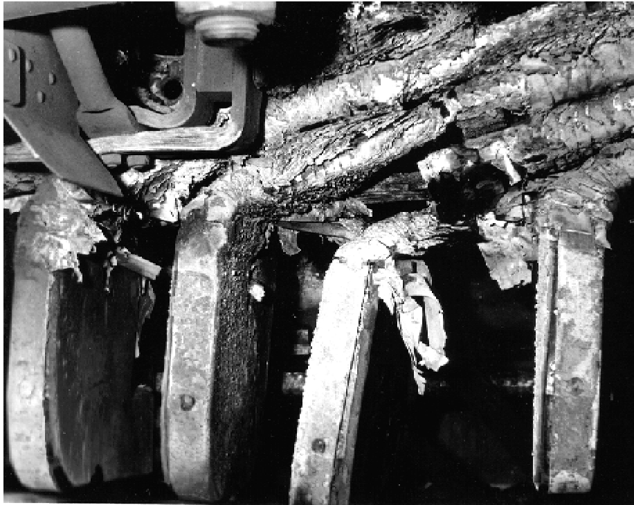
Рис. 4.3 Разрушение нижних лобовых частей обмотки статора в результате междуфазного короткого замыкания
