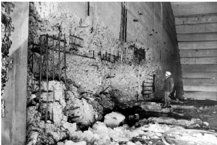
Рис. 2.52 Разрушение дна и стен водосбросов II яруса
