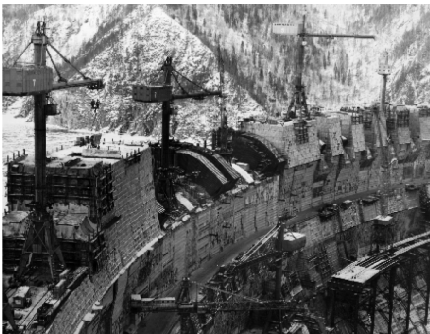
Рис. 2.46 Водосбросная плотина Саяно-Шушенской ГЭС. Монтаж облицовки входных участков водосброса
